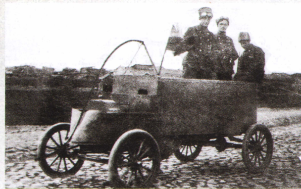
Автомобиль «Форд Т» с корпусом из «железной» брони А.А. Пороховщикова на испытаниях, 1915 год.
